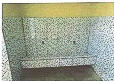
Foto 3: Sustitución de mingitorios
