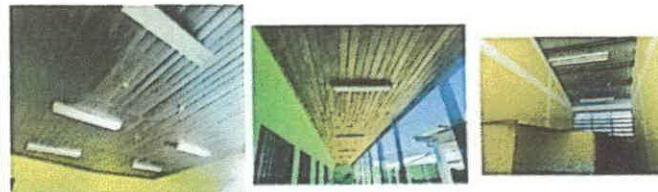
Foto 8: Sustitución de lámparas tipo led en cocina, corredor y sanitarios.
