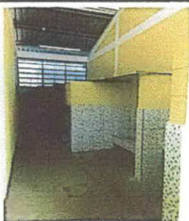
Foto 5: Sustitución de azulejo interior y exterior
