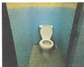
Foto 2: Sustitución de inodoros normales a infantiles
